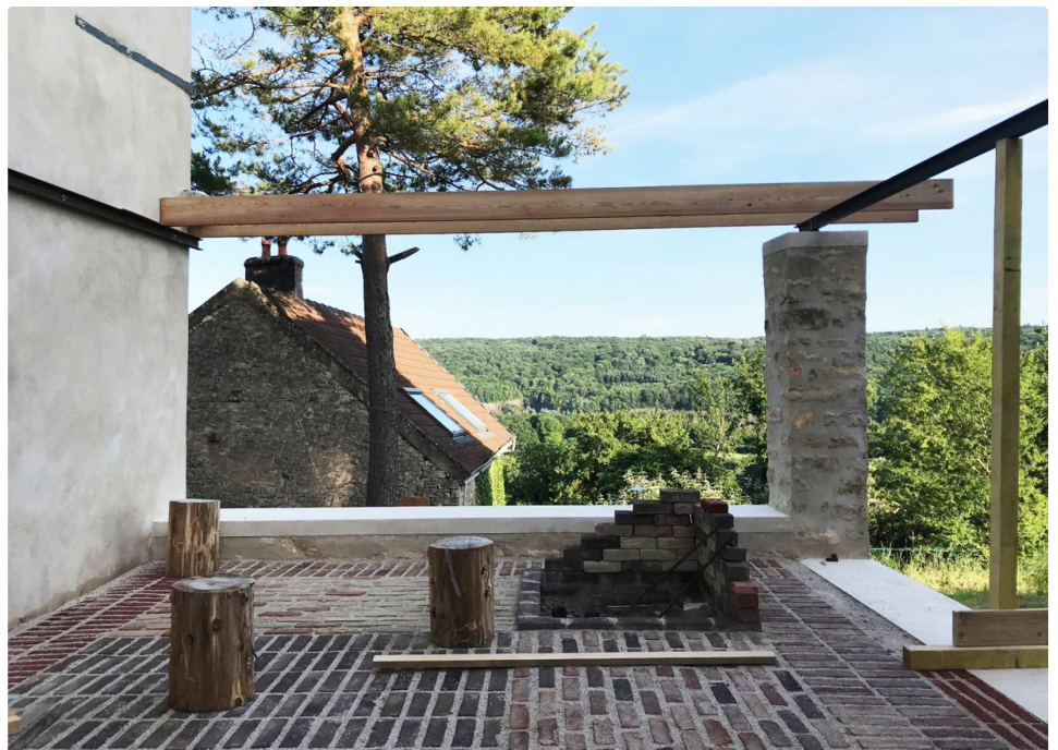
↑ Réhabilitation d'une ancienne cloutière en atelier et logement dans le village d'Offlanges (39290) par Alexandre Lenoble architecte. © Alexandre Lenoble.
